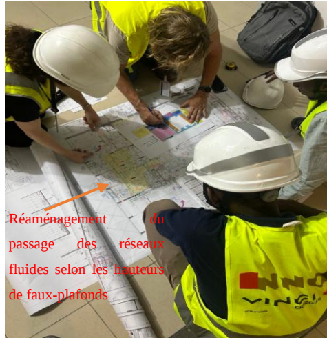
Figure 14 : réunion particulière sur site Architecte-OPC-BET fluides et VINCI
