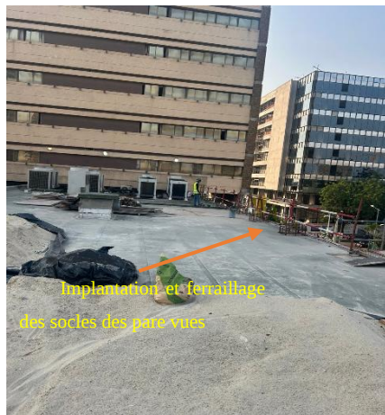
Figure 16.1 : implantation et ferrailage
