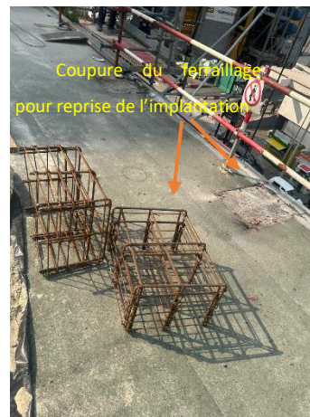
Figure 16.2 : Dépose pour reprise du ferrailage
