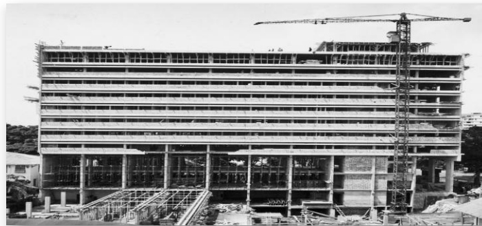
Figure 8 : Façade Nord lors de la construction de l'ancien bâtiment
