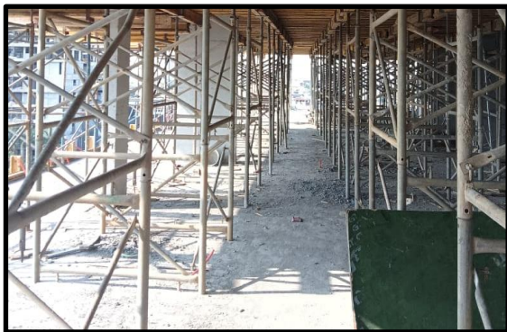
Figure 11 : Image de tours de coffrage
