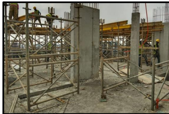
Figure 10 : Image de tours de coffrage
