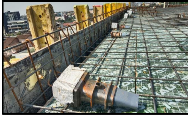
Figure 16 : Illustration de la pose des dérives d'ancrage
