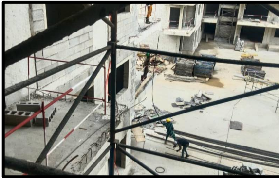
Figure 24 : Image illustrative du transport manuel du ferrailage passif
