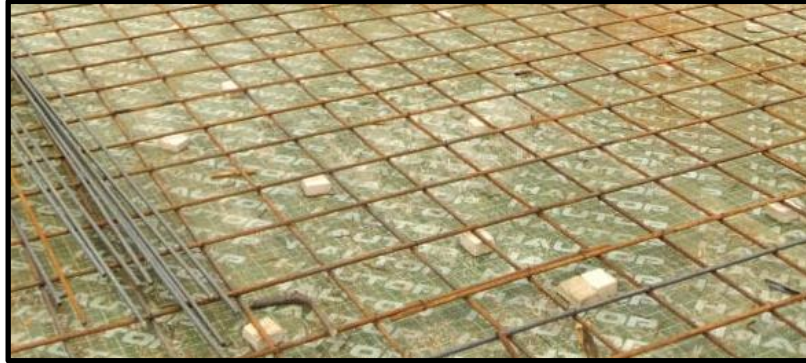
Figure 12 : Ferrailage de la nappe inférieure d'une dalle en béton précontraint par post-tension
