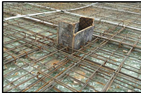
Figure 15 : Ferrailage au niveau des trémies
