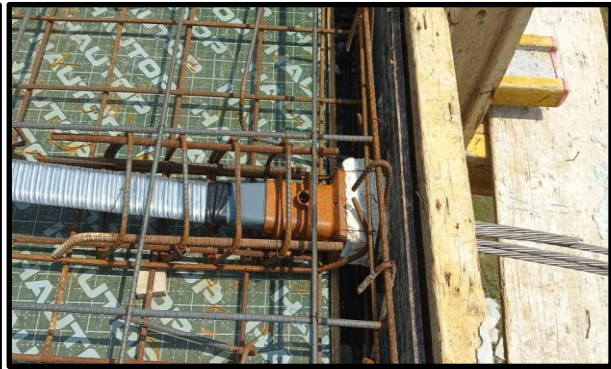
Figure 17 : Image de l'ancrage actif des torons de précontrainte après insertion
