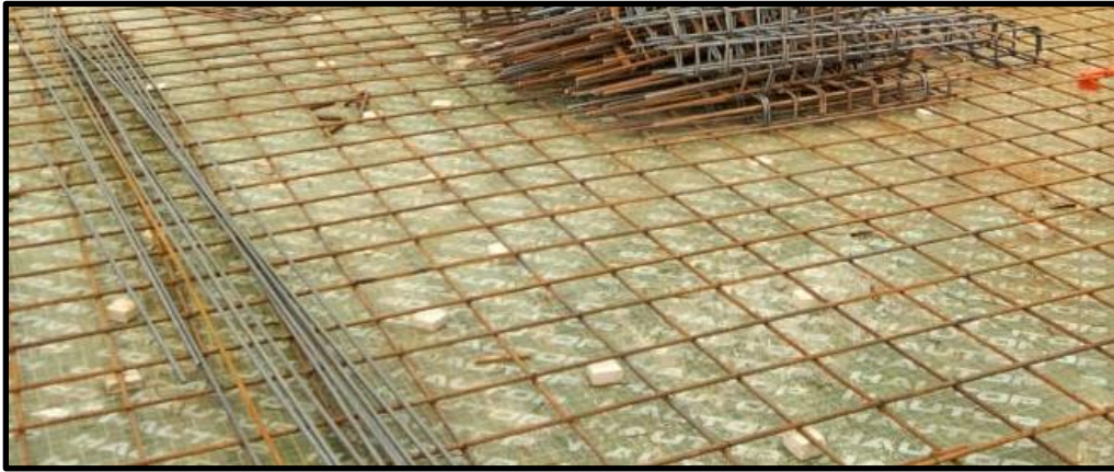
Figure 8 : Ferrailage la nappe inferieure de la dalle en béton précontrainte par post-tension
