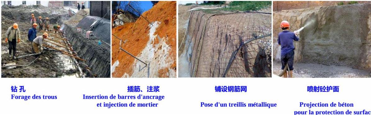
**Figure 23** : Les différentes étapes de la mise en place de soutènements de mur de tirants
