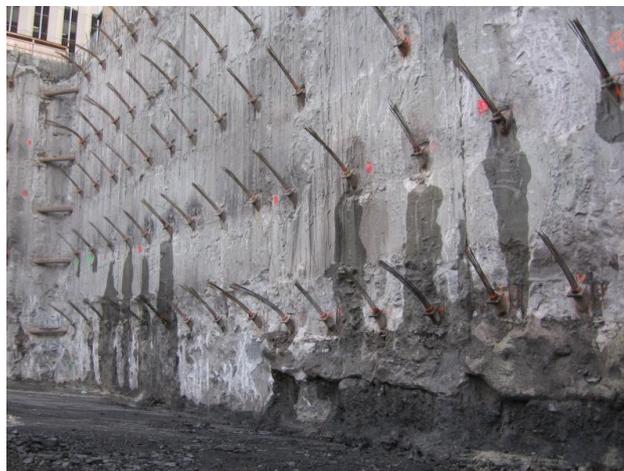
**Figure 26** : Une paroi moulée avec ancrages
