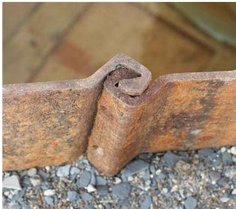
**Figure 18** : Des serrures a la jonction de deux palplanches
