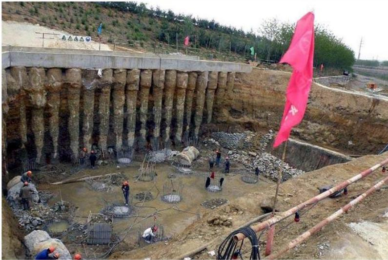
**Figure 7** : Les pieux en béton projeté
