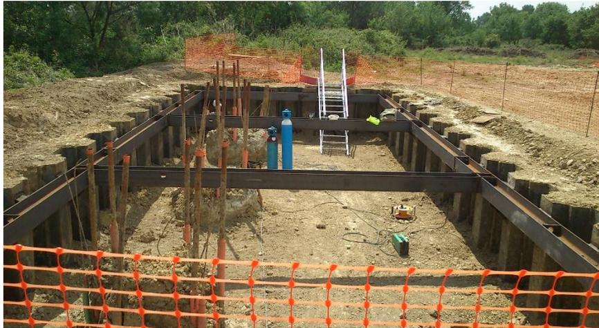
**Figure 19** : Des palplanches en acier
