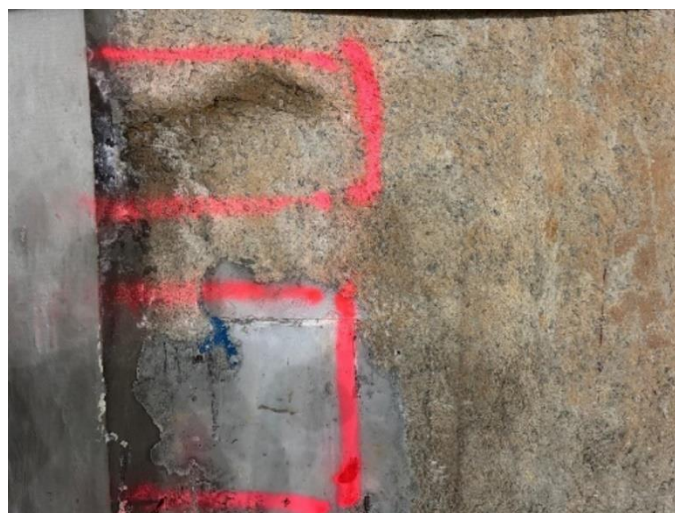
Figure 54 : Marquage panneau P3 paroi moulée
