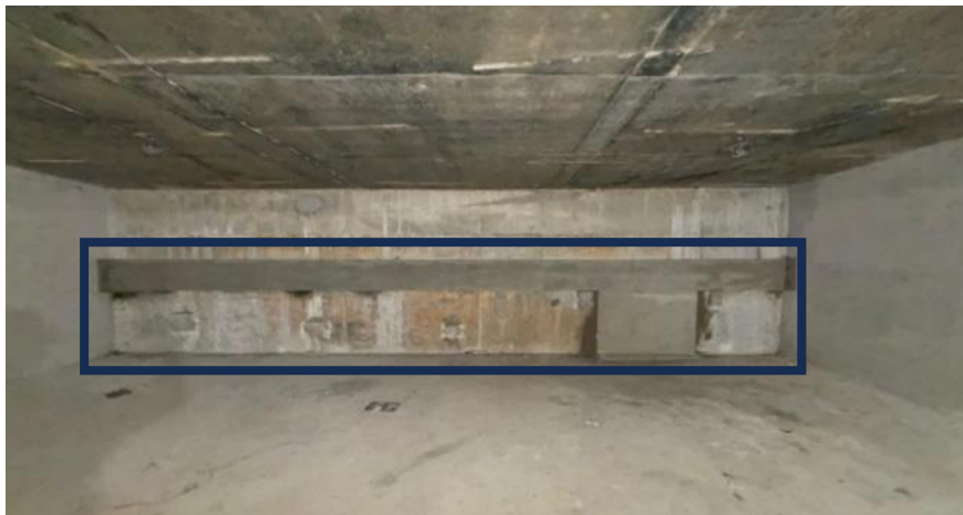
Figure 52 : Cuvelage du panneau P5 de la paroi moulée zone D SS1
