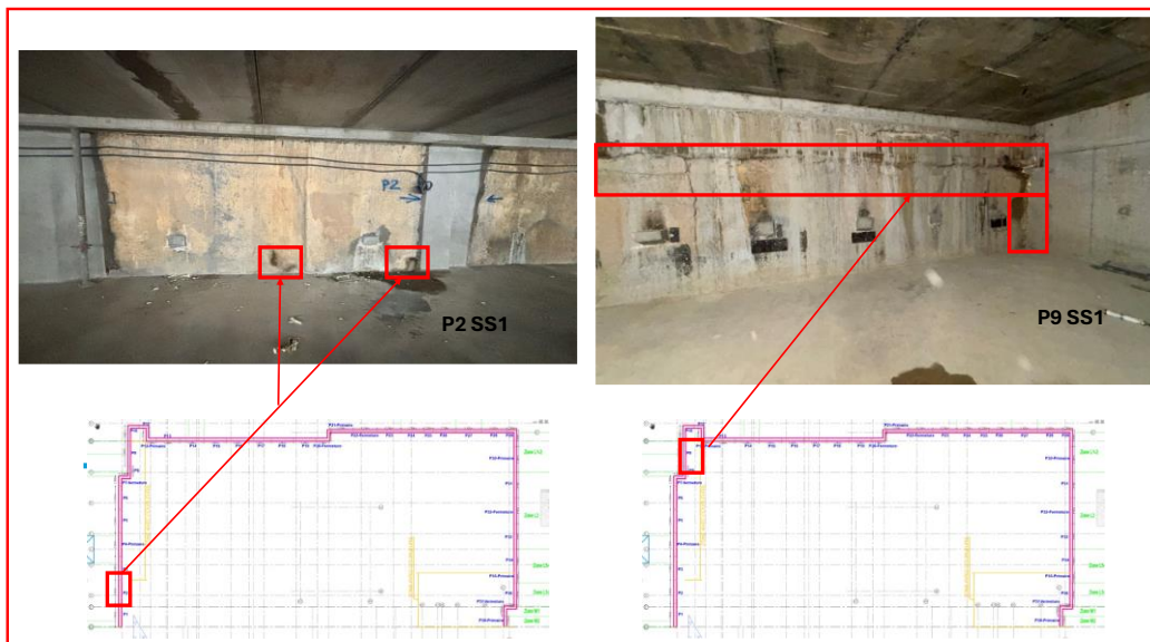
Figure 51 : Extrait emplacement des percolations d'eau de la paroi moulée
