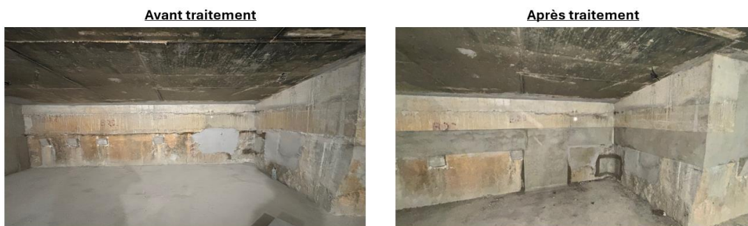
Figure 62 : Traitement du panneau P7 de la paroi moulée
