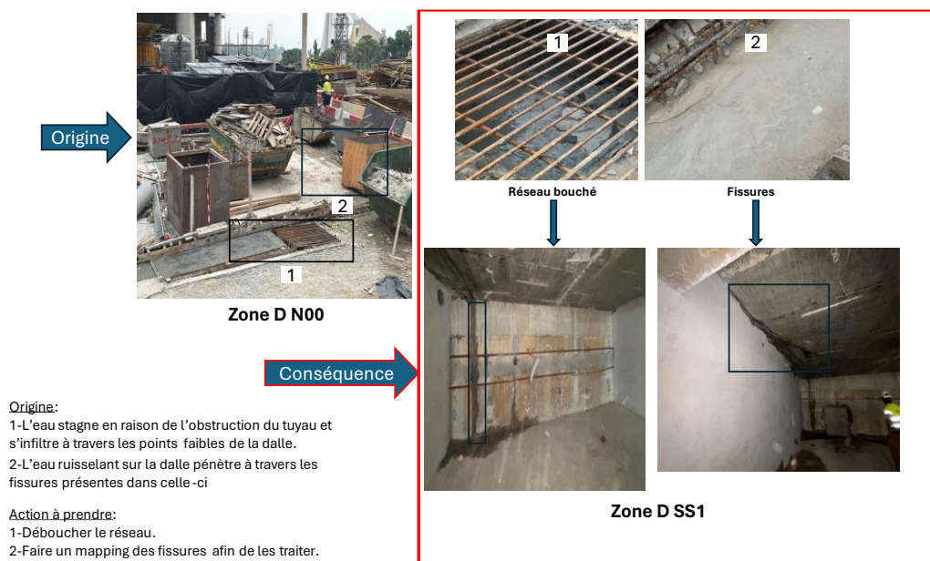
Figure 50 : Extrait analyse des percolations d'eau paroi moulée
