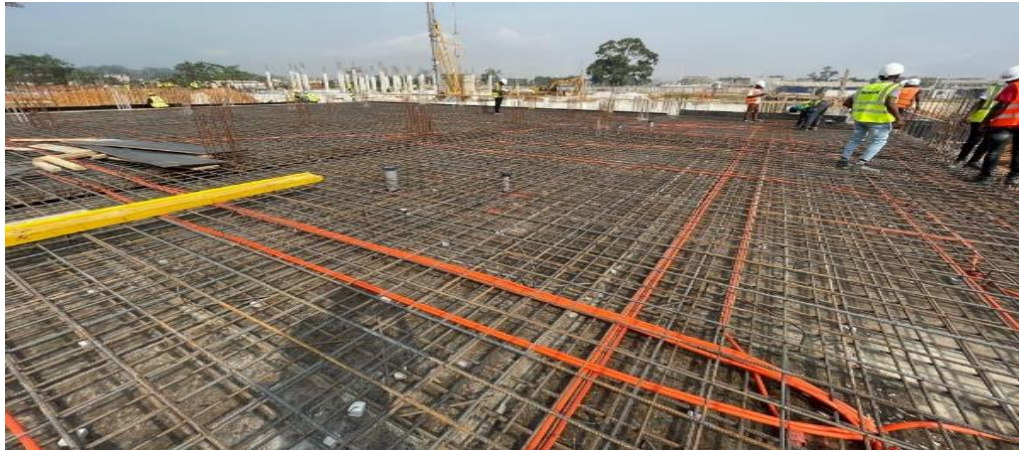
Figure 10 : Ferrailage d'une dalle en Béton armé
