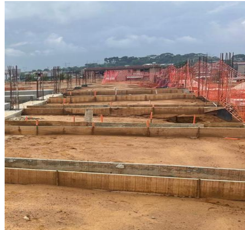
Figure 21: Coffrage de béton de propreté
