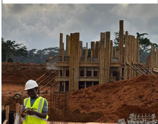
Figure 22: Coffrage de gros béton
