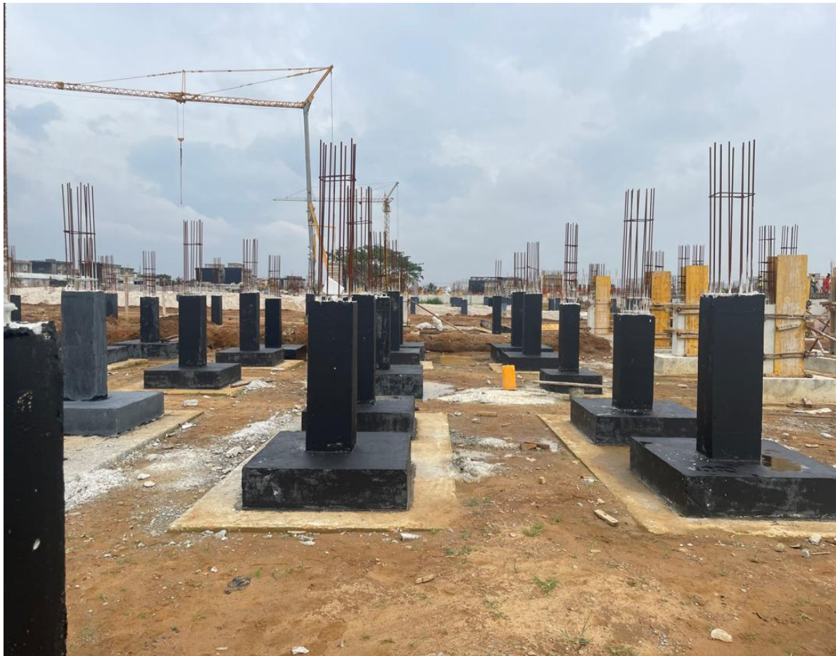
Figure 29 : Application de la deuxième couche d'étanchéité sur les semelles isolées et les Prépotaux
