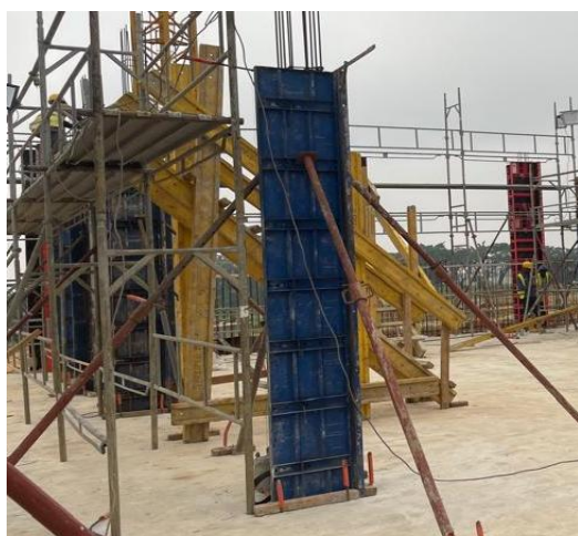
Figure 23 : Coffrage des poteaux
