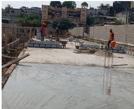
**Figure 18 : bétonnage de dallage**
