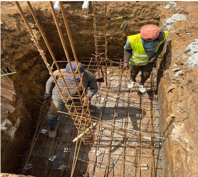
***Figure 13 : pose de ferrailage de semelle isolée***
