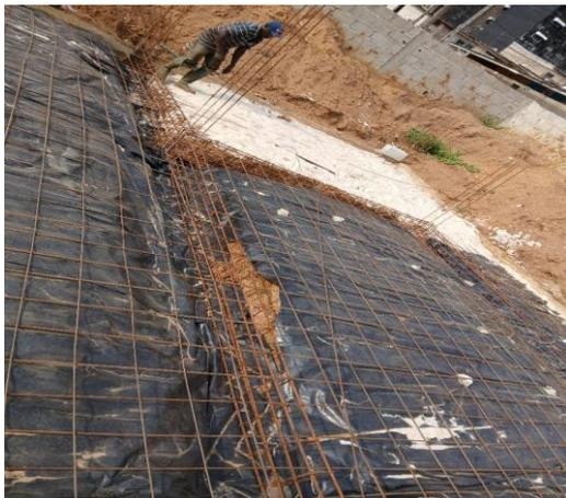
**Figure 19 : pose de ferrailage du dallage**
