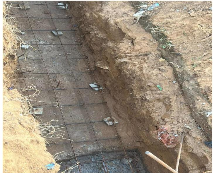
***Figure 14 : pose de ferrailage de semelle filante***
