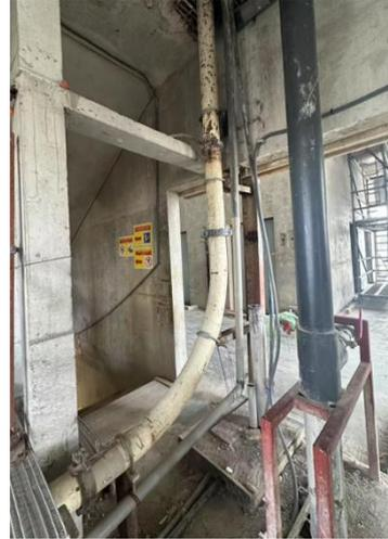
Figure 50: Conduite de bétonnage
