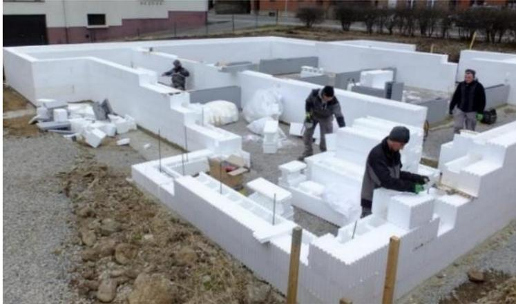
*Figure 7: coffrage à béton isolant*
