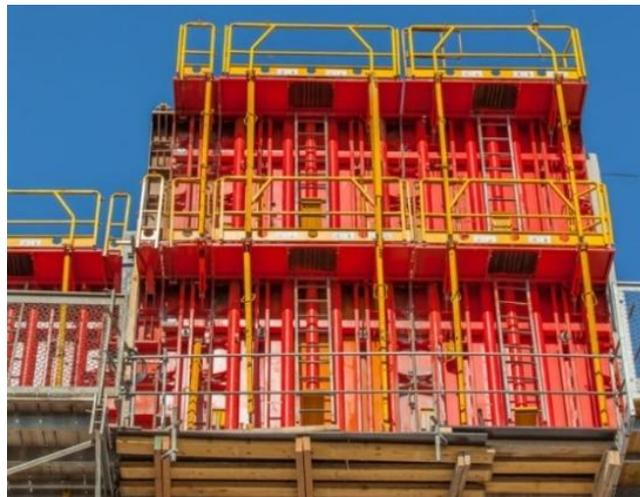
*Figure 6: coffrage métallique*
